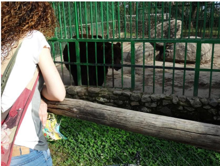
**Figura 1.2.11.** Instalación de los osos. La distancia de separación entre los barrotes es muy grande y se pueden introducir perfectamente los brazos. La segunda barrera de separación es baja y fácilmente franqueable.
