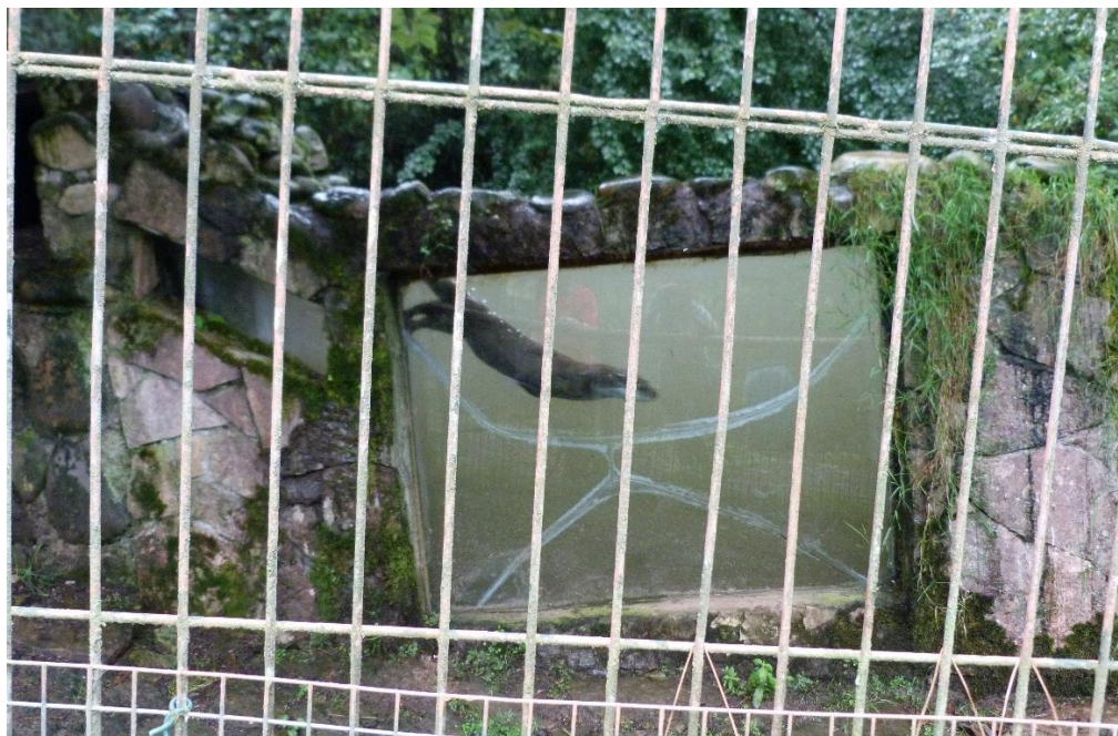
Figura 5.11. Instalación de las nutrias. Vallas oxidadas, vidrio dañado y agua sucia.
