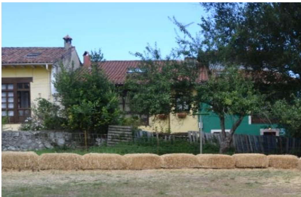
Figura 2.2.1 y Figura 2.2.2: Se puede observar la valla que separa el patio de la calle.
